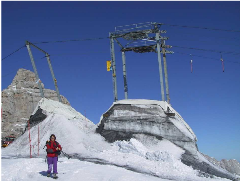
Kurzfristige Verbesserungen durch Abdeckung möglich.
